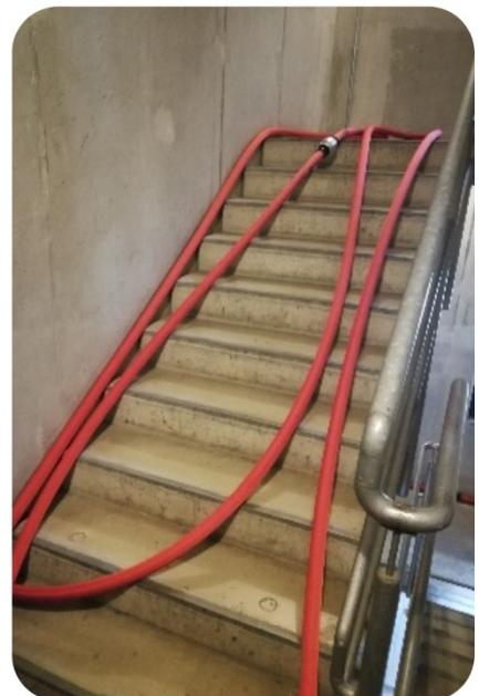
Abb. 8/9: Verlegung der Schlauchleitung über die Treppe. Die Schlauchreserve wird auf die nach oben führende Treppe verlegt.
