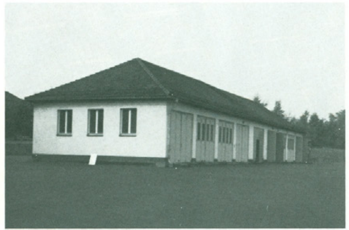
Die erweiterte Fahrzeughalle (fertiggestellt 1951)
