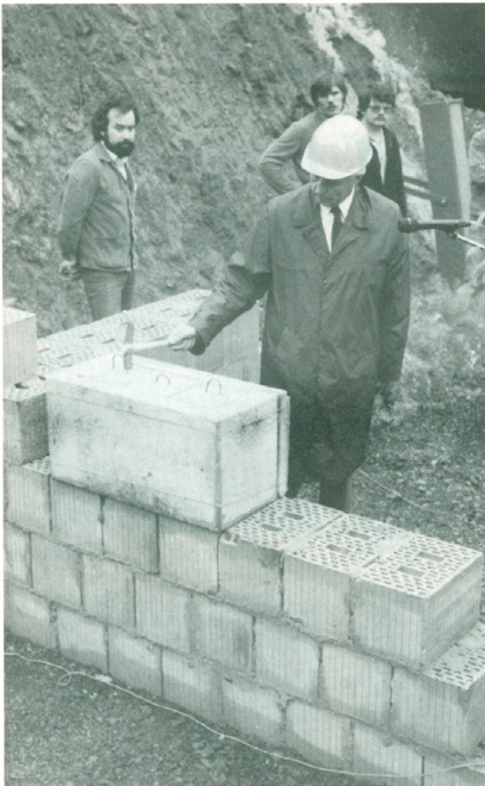
Grundsteinlegung für den III. Bauabschnitt durch Innenminister Dr. Herbert Günther
