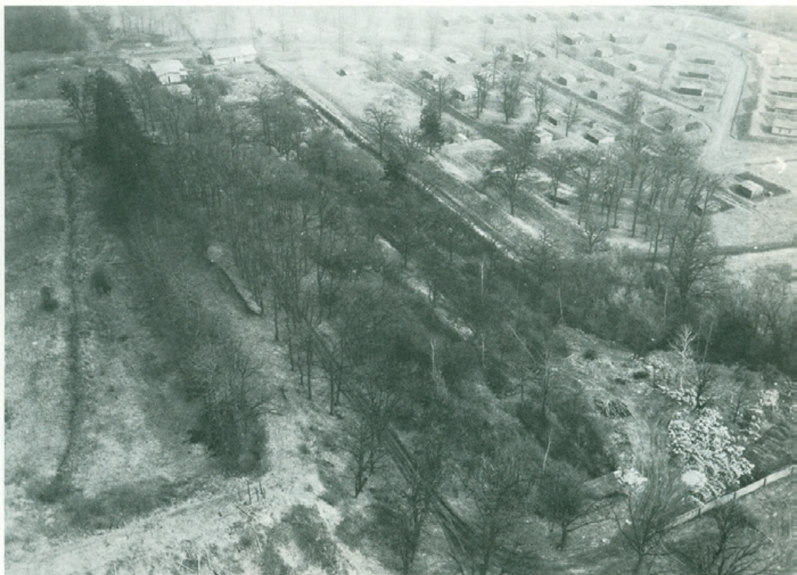
Der Standort „Dönche I“ vor Beginn der Baumaßnahmen. Rechts oben im Bild das belgische Munitionsdepot.
