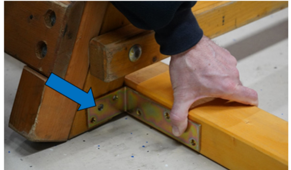
Abbildung 7: Winkelverbinder ausgerichtet
