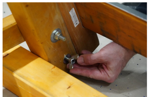
Abbildung 14: Anbringen Flügelmutter
