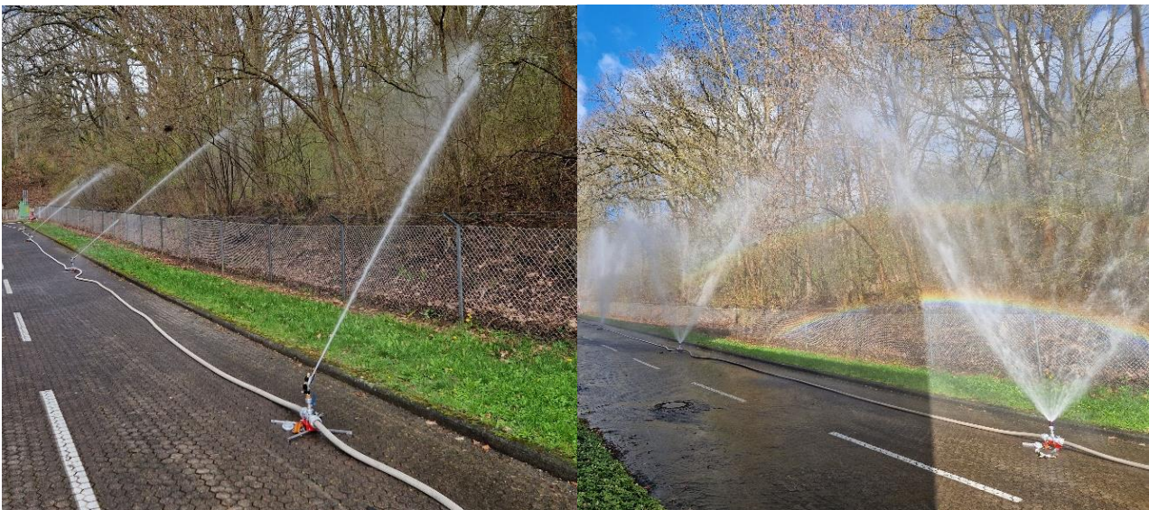
Abb. 14: Kreisregnersystem im Einsatz (links: Kreisregneraufsatz, rechts: Aufsatz zur Bildung einer Wasserwand)
