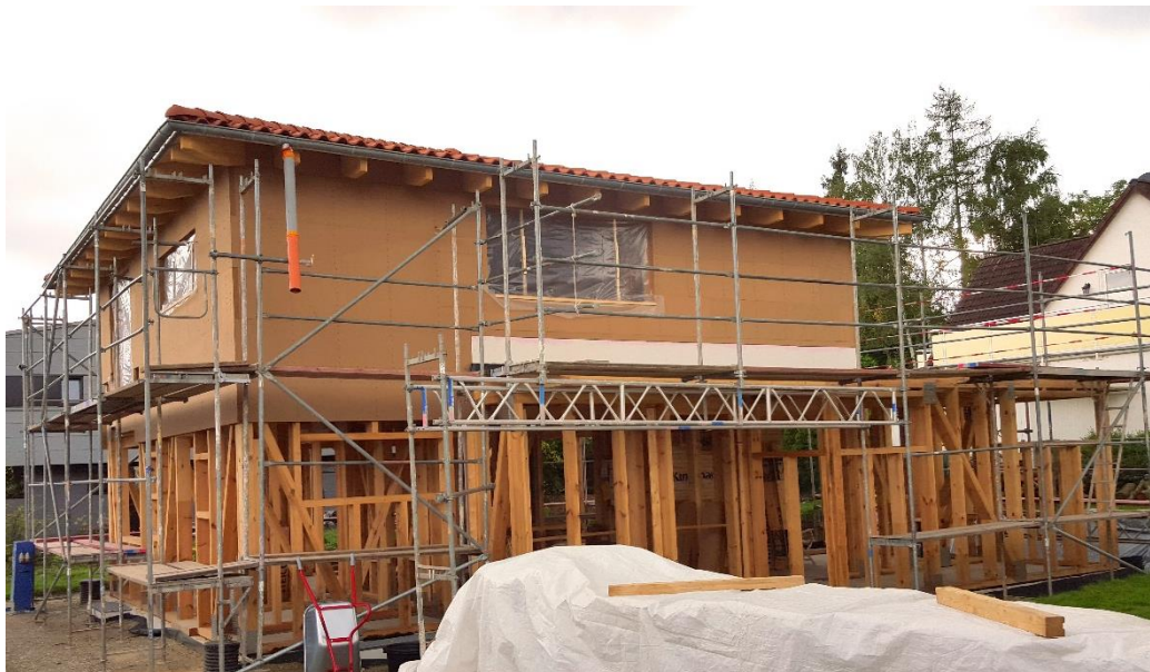
Abbildung 13_Bild_BK13_Holzskelettbau_Quelle: Kneip
