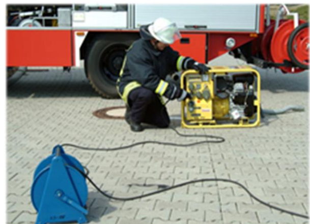
Abb. 7: Inbetriebnahme des Stromerzeugers
