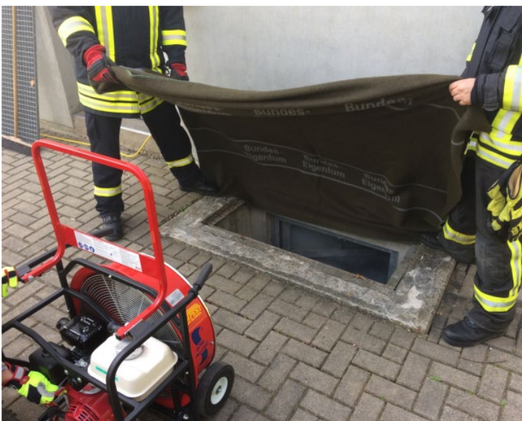
Abb. 14: Luftstromlenkung mittels Woldecke
