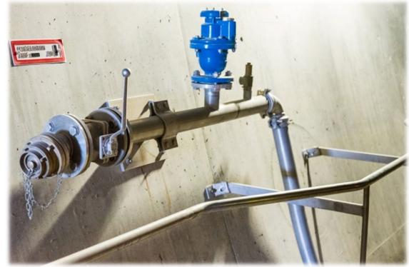
Abbildung 49: Schlauchanschlusseinrichtung
