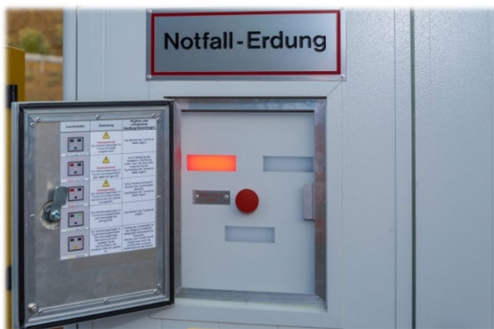
Abbildung 14: Leuchtmelder und Nottaster einer OLSP
