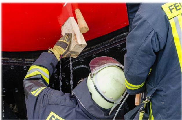
Abbildung 19: Abdichten eines Risses im Kessel
