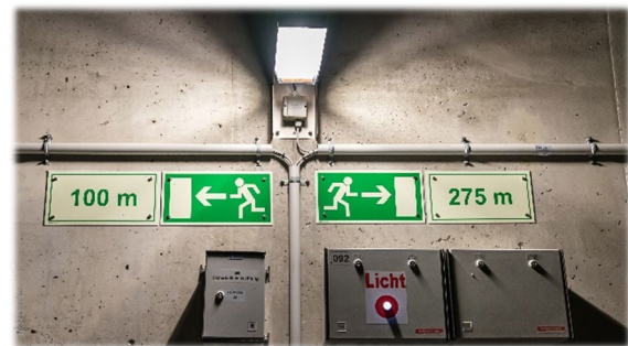
Abbildung 50: Fluchtwegkennzeichnung unter Notbeleuchtung
