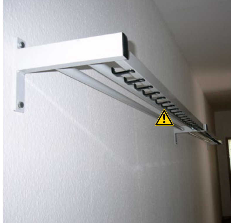
Bild 9 Garderobenhaken in Augenhöhe bilden Verletzungsgefahren
