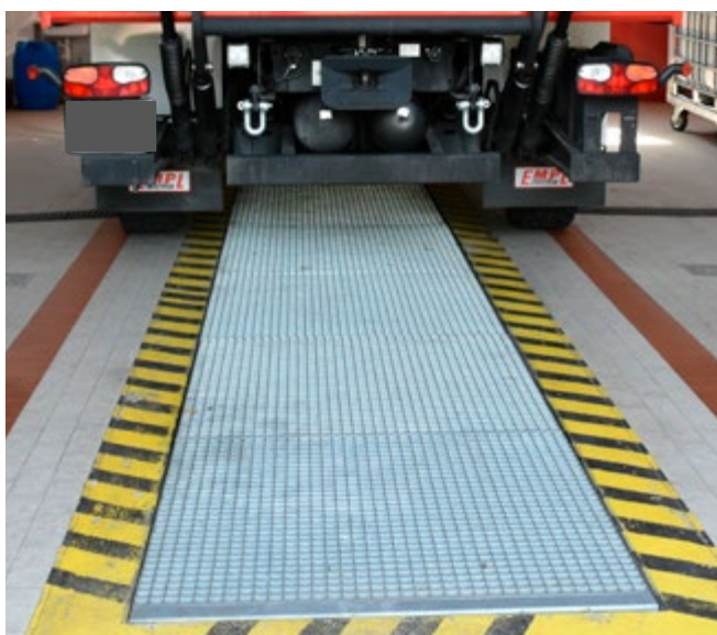
Bild 40 Markierte Grubenränder
