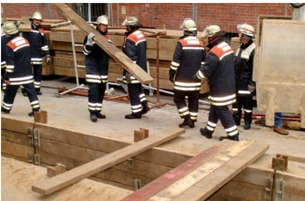
Behelfsmäßiger Übergang aus Bohlen
