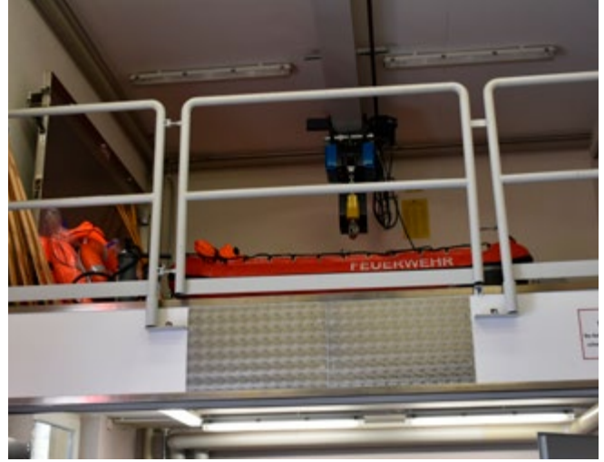
Bild 43 Zwischenboden (Fußleiste, Steckgeländer)
