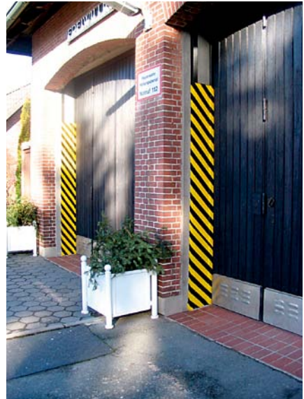
Gelb-schwarze Gefahrenkennzeichnung der Tordurchfahrt nach außen
