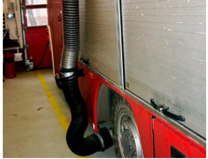
Bild 27 Regelkonform installierte Abgasabsaugung
