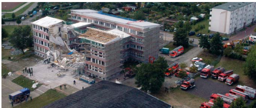
Einsturz eines Schulgebäudes durch unsachgemäße Bauarbeiten
