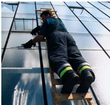
Beschädigte Glasscheiben eines Gewächshauses werden nach Beschädigung durch Hagelschlag vorsichtig entfernt (Feuerwehrlärm und Schutzjacke wurden auf Grund großer Hitze abgelegt).
