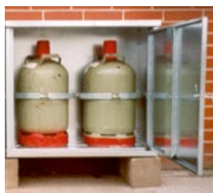
Bild 44 Kleinlager für Flüssiggasflaschen im Freien
