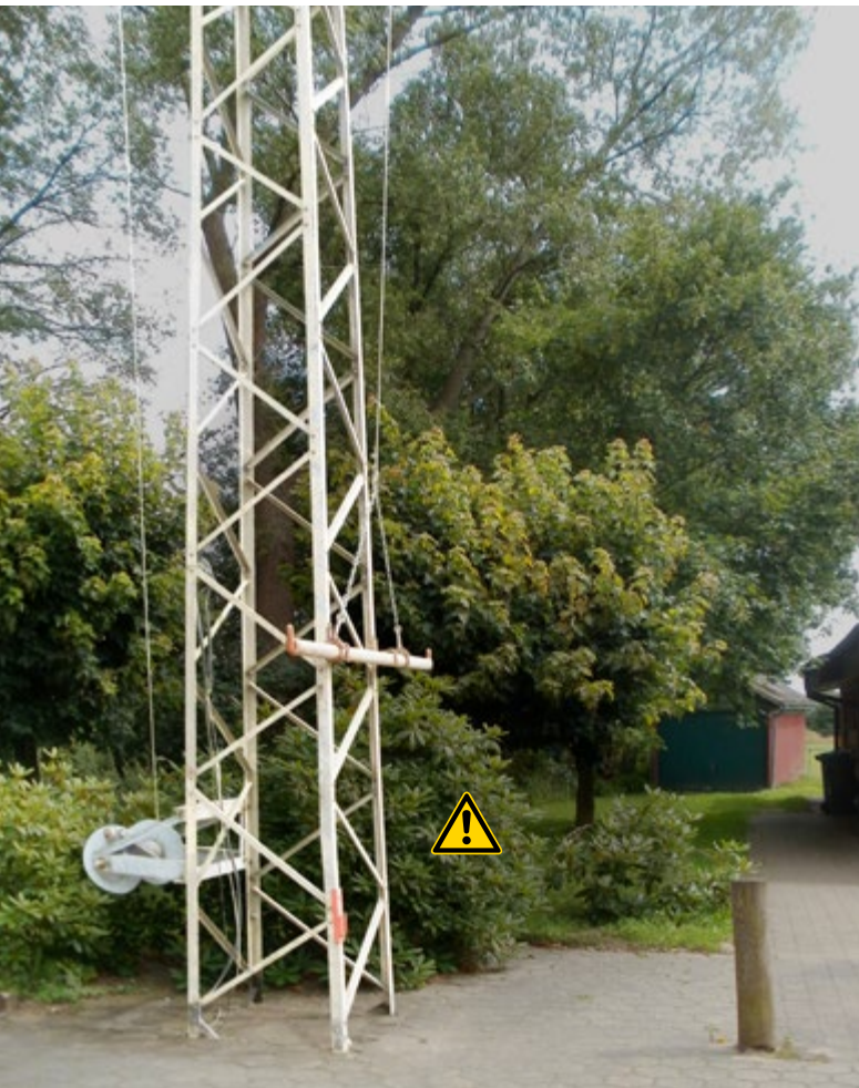
Bild 50 Ungesicherter Schlauchmast neben dem Feuerwehrhaus
