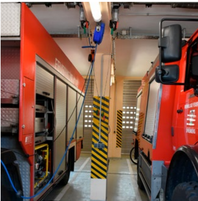
Bild 20 Als Übergangslösung: Markierung der einengenden Gebäudeteile
