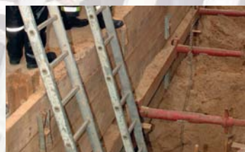
Sicherer Zugang in den Graben über Leitern
