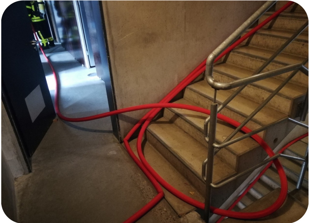
Abb. 10: Das Nachziehen der Schlauchreserve wird durch das Eigengewicht unterstützt.
