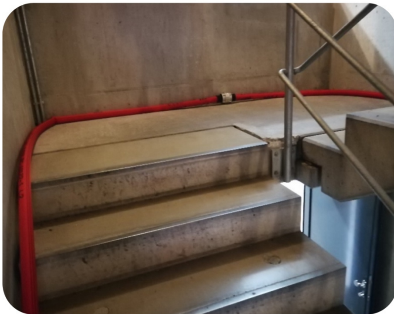
Abb. 8/9: Verlegung der Schlauchleitung über die Treppe. Die Schlauchreserve wird auf die nach oben führende Treppe verlegt.
