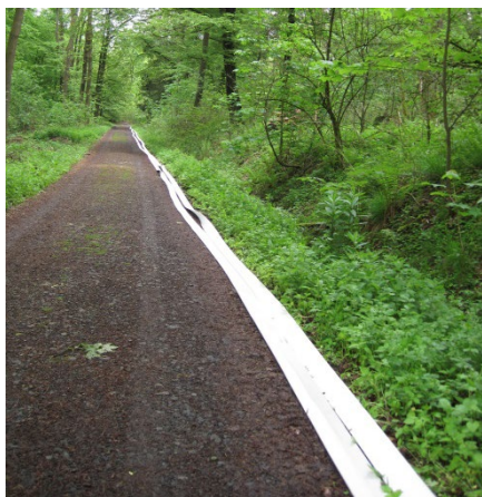
Abb. 20: Verlegte Doppelleitung
