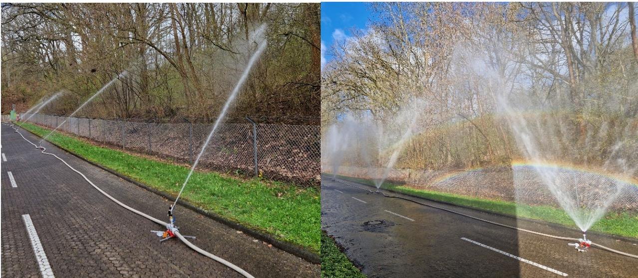
Abb. 16: Kreisregnersystem im Einsatz (links: Kreisregneraufsatz, rechts: Aufsatz zur Bildung einer Wasserwand)
