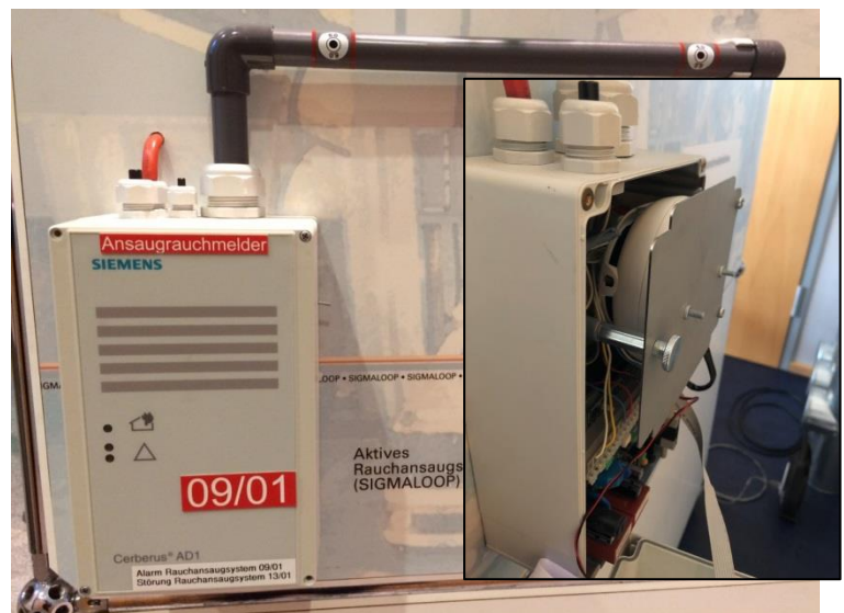
Abb. 28: Geöffneter Ansaugrauchmelder
