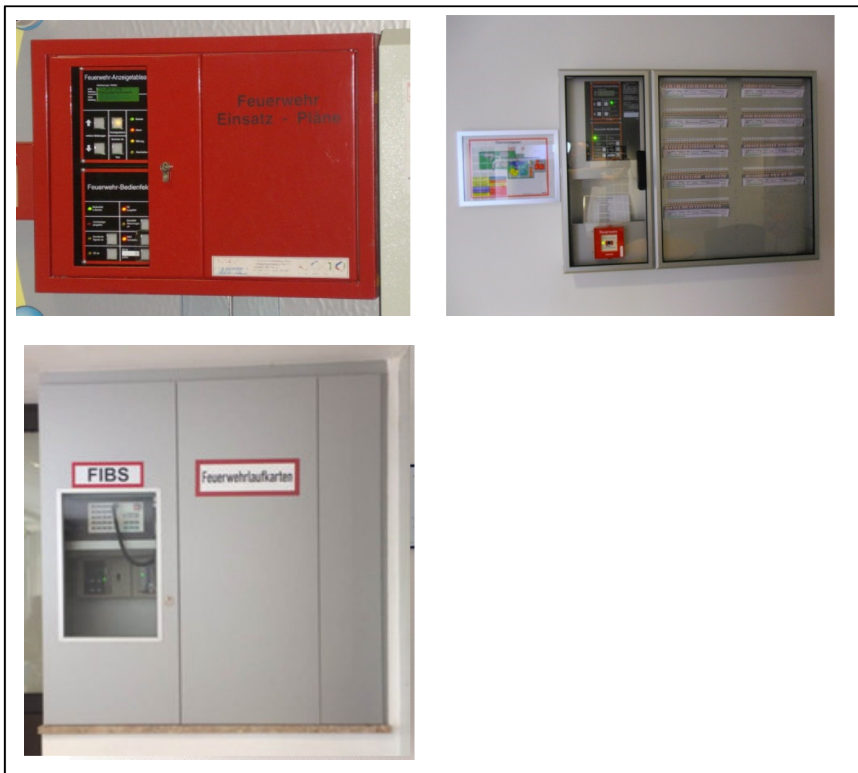
Abb. 13: Verschiedene Ausführungen der Ables- und Bedieneinrichtung
