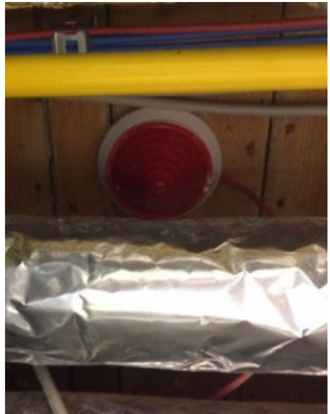
Abb. 22: Zwischendeckenmelder mit Staubschutzkappe während Bauarbeiten
