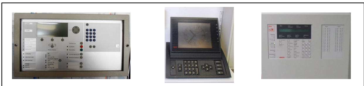
Abb. 11: Beispielhafte BMZ diverser Hersteller
