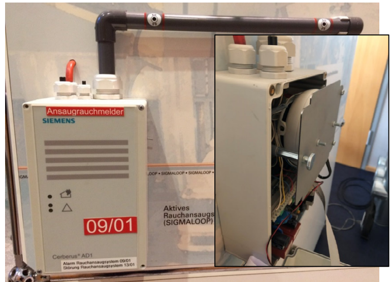
Abb. 28: Geöffneter Ansaugrauchmelder
